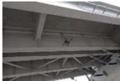
ドローンによる桁下の点検
