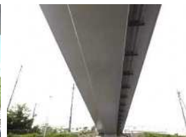
鏡石橋 :PCラーメン橋(東北道の跨道橋) ○前回点検:平成27(2015)年度実施 下部工:剥離・鉄筋露出 判定区分Ⅲ(健全度D) ○補修工事:平成29(2017)年度実施 表面被覆材塗布工、剥落防止工 ○今回点検:令和2(2020)年度実施 判定区分Ⅰ(健全度A)
