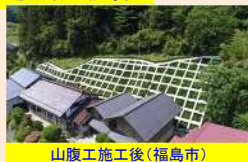
山腹工施工後(福島市)
