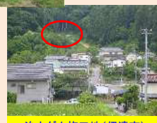
治山ダム施工地(伊達市)
