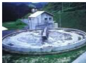
畜産環境対策施設
