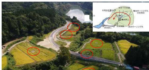
集水井設置 揚津地区（喜多方市）
