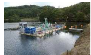
実施例④ ポンプによる浚渫除去
