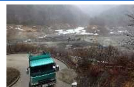
土砂運搬状況
