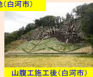
山腹工施工後(白河市)
