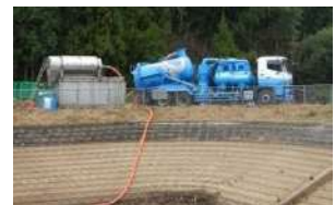
実施例② 強力吸引車による浚渫除去
