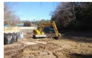
実施例③ 底質の掘削除去
