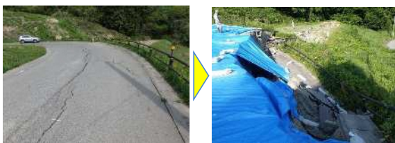
平成30年4月下旬に発生した融雪による大規模地すべり災害 左)平成30年5月1日撮影 右)平成30年6月3日撮影
