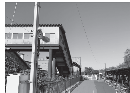
駅東側に設置された防犯カメラ
