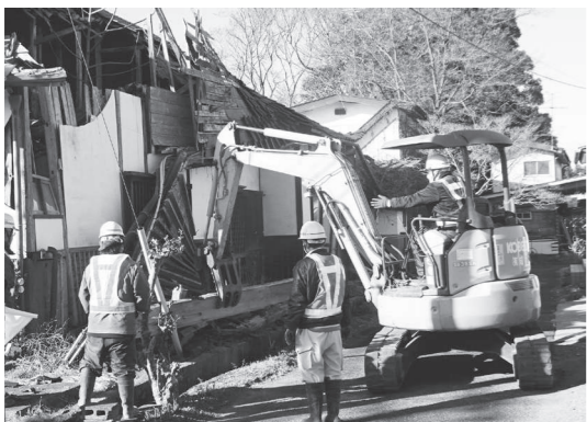
重機で崩れていた屋根の一部を撤去する様子
