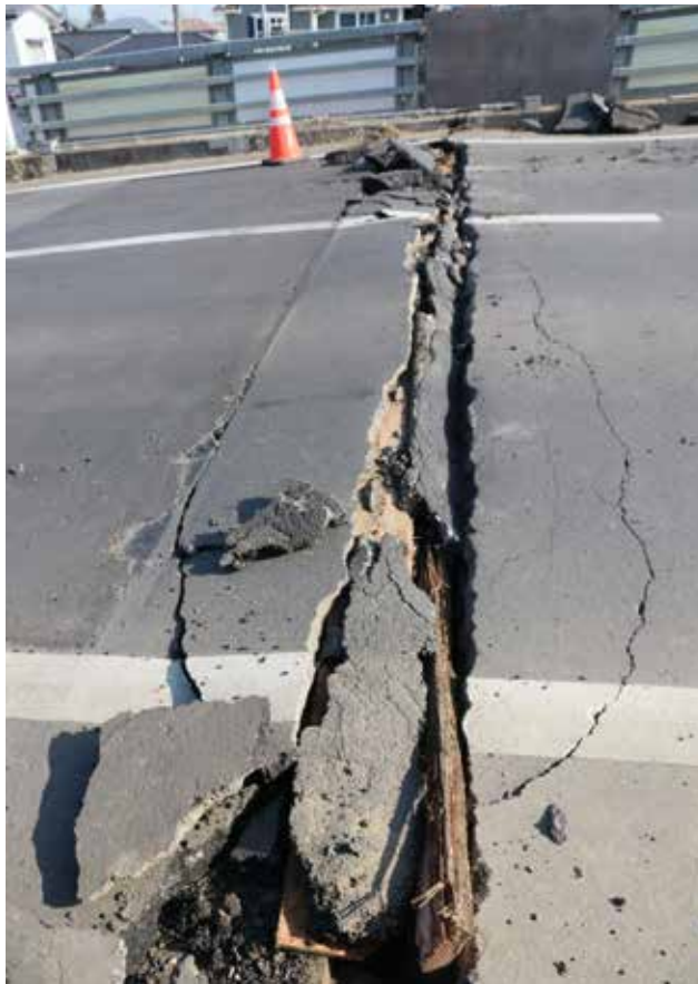
地震で接合部に大きな亀裂が入り、通行止めとなった笠石高架橋。東北本線の連休で笠石地内の踏切では遮断機が下りたままの状態となり(下)、町の東西の往来に支障を来した
