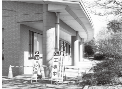
図書館南側の工事箇所
