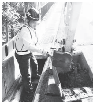
側溝の堆積物撤去作業の様子
