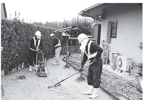
住宅除染の様子
