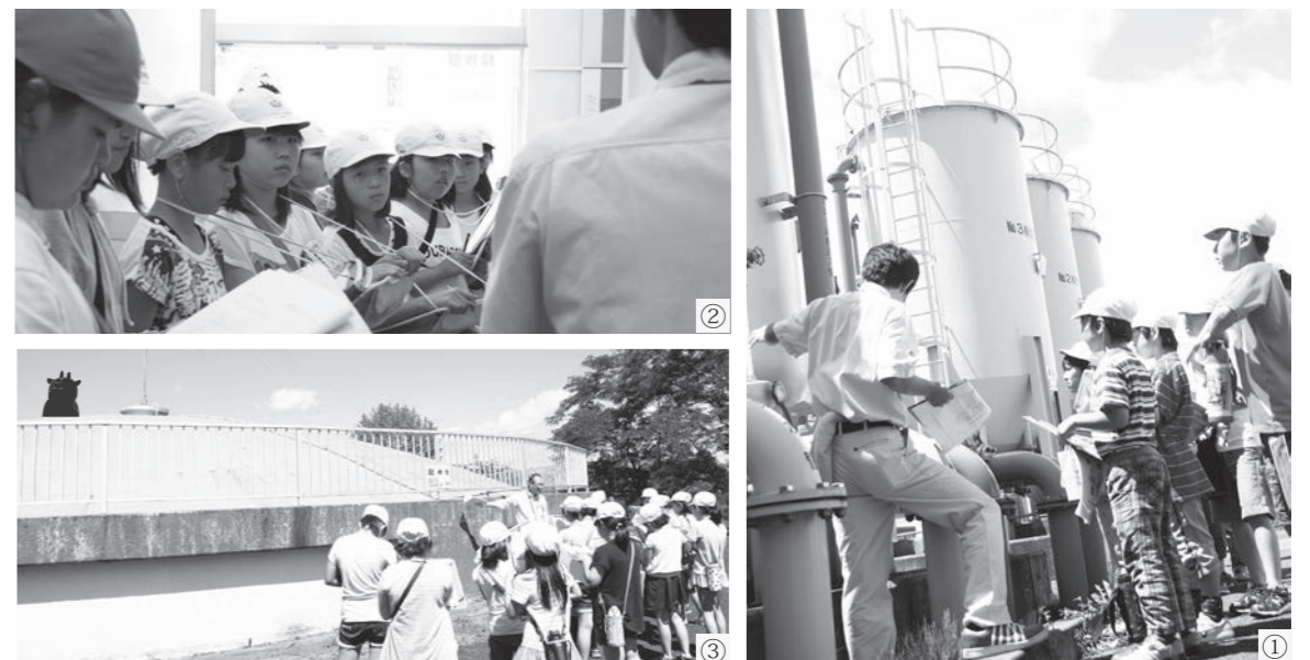
① 中央の大きなタンクが「ろ過装置」です ② 「中央監視盤」の説明を真剣に聞く児童たち ③ 敷地の中央には大きな「配水池」があります
