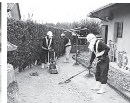
宅地内対象箇所の除染作業
