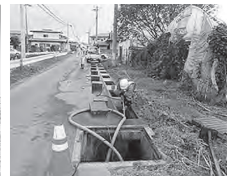
地区内道路側溝の除染作業
