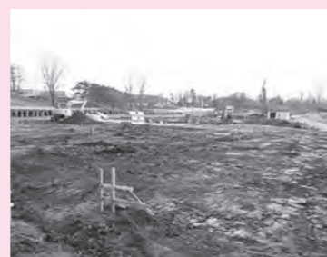
高久田地区仮置場（造成中）
