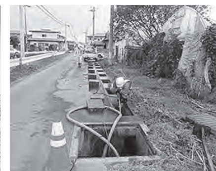
地区内道路側溝の除染作業
