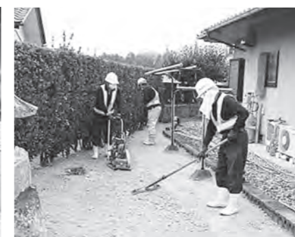
宅地内対象箇所の除染作業
