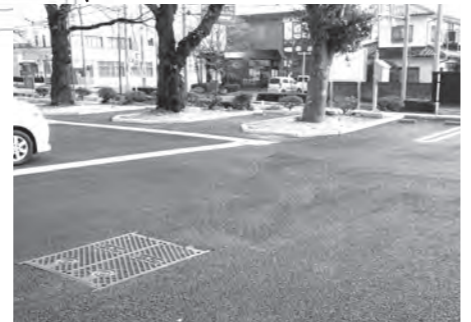
駐車場内に耐震性貯水槽を設置
