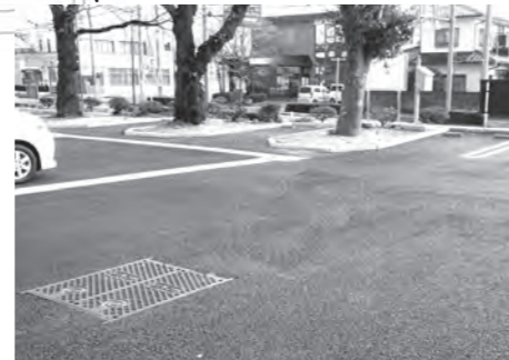
駐車場内に耐震性貯水槽を設置
