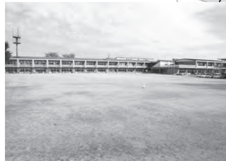
仮設校舎が取り壊され、きれいになった校庭
