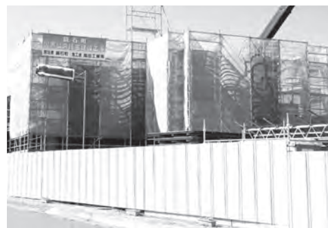
建築が進む災害公営住宅
