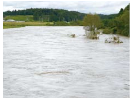
▲増水した阿武隈川、向岸の玉川村では堤防から溢水
