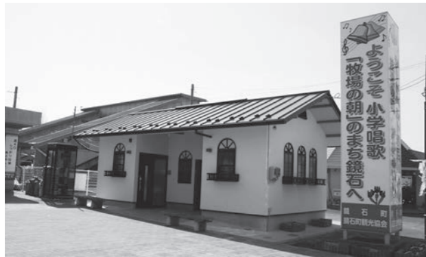
▲停電時や断水時でも使用可能な駅前トイレ
