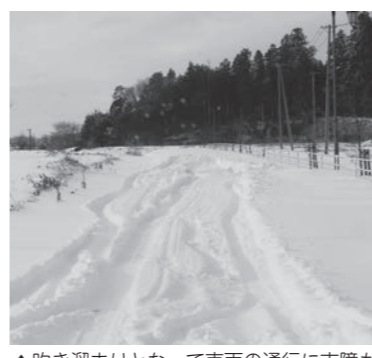
吹き溜まりとなって車両の通行に支障も
