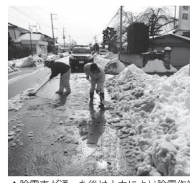
除雪車が通った後は人力により除雪作業
