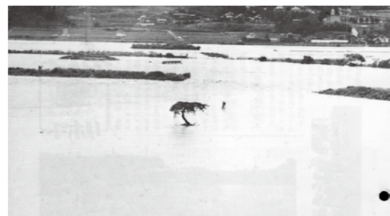
▲約120mにわたり決壊した阿武隈川左岸堤(昭和61年)
