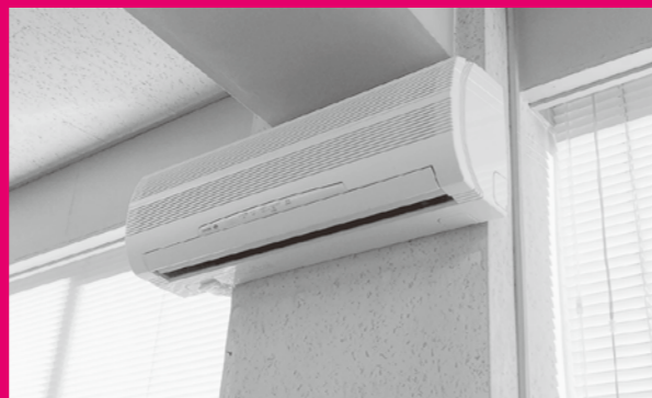
地区集会所エアコン設置事業
