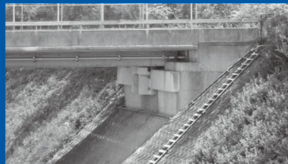
高速道路跨道橋修繕工事
