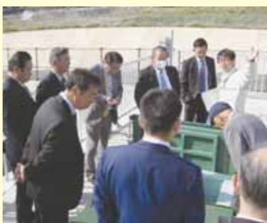
全議員により南高久田ポンプ場を視察
