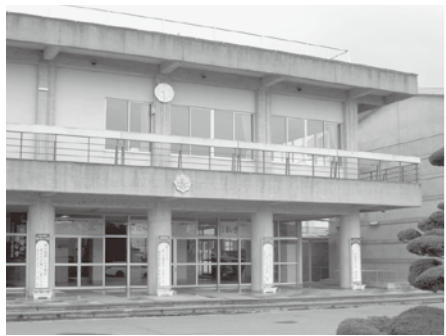
中学校にもエアコン設置
