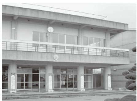
中学校にもエアコン設置
