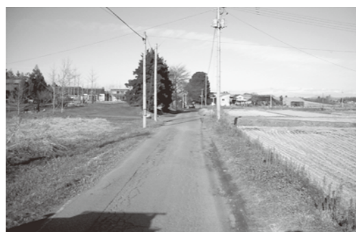
久来石行方蓮池西線工事は来年度再開
