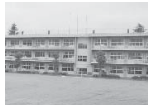
解体工事を待つ一小校舎
