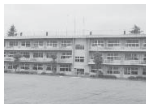
解体工事を待つ一小校舎
