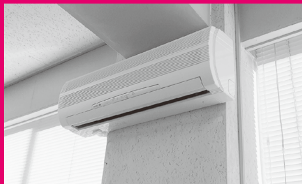
地区集会所エアコン設置事業
