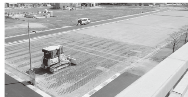
宅地造成が進む駅東第1土地区画整理事業(第1工区)
