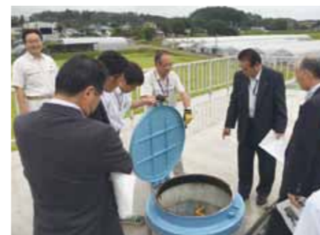
産業厚生常任委員会・成田浄水場改修工事
