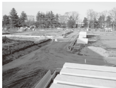
工事が進む駅東地区画整理
