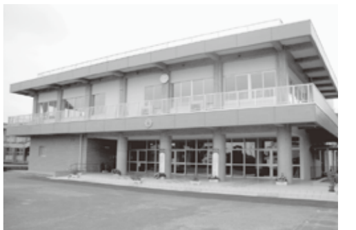
改修された中学校（1期工事）
